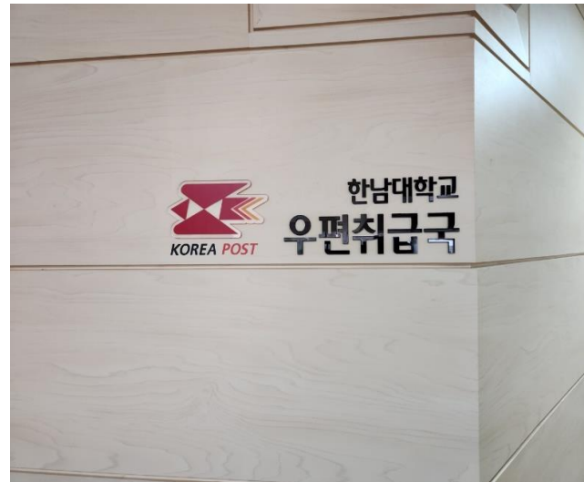
내부벽면 스카시 설치
