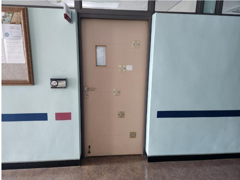
방화문 2개소 신규설치-기존문사진
