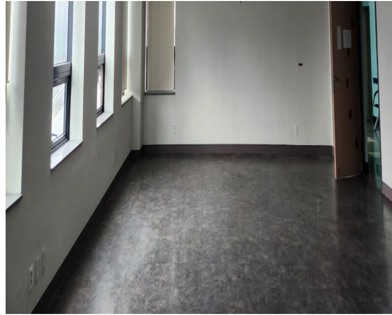
철거부분 바닥 데코타일 마감
