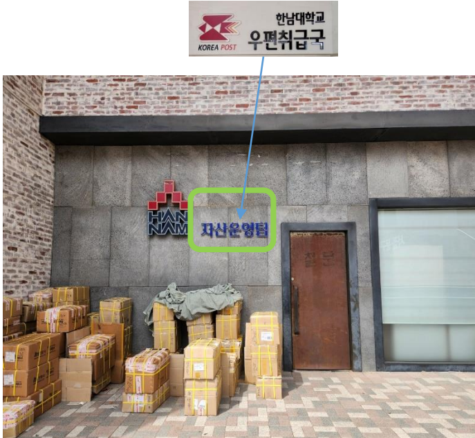
자산운영팀 스카시 철거/한남대학교 우편취급국 스카시 설치
